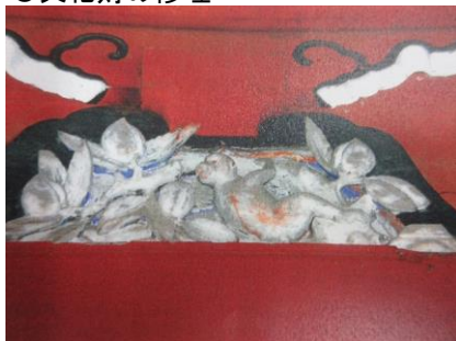
勝福寺本堂の装飾の塗装(施工前)
