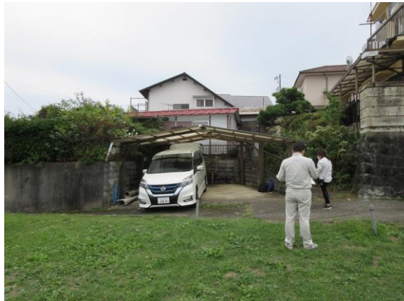
公有地化実施中の総構城下張出の一部(補償調査状況)
